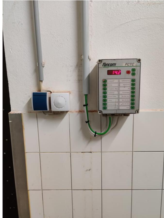
Steuerung der Heizung via E-Motor Kugelhahn in Verbindung mit Temperatur-Sensor
